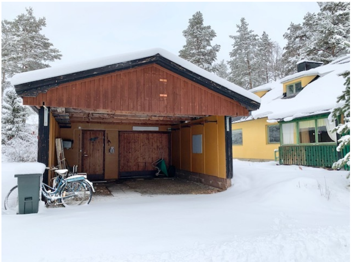
Garage och förråd
