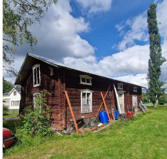
Byggnad i timmer/trä uppförd under 1700-talet med plåttak. Torpargrund. Byggarea ca 70 m 2 . Byggnaden har renoveringsbehov.
