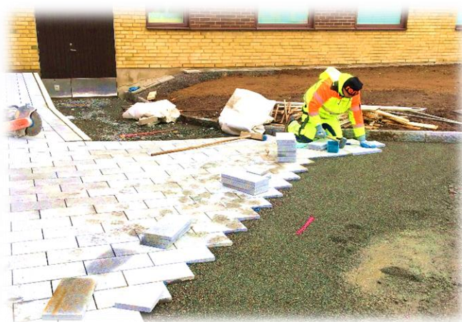
Plattläggning pågår vid 6B
