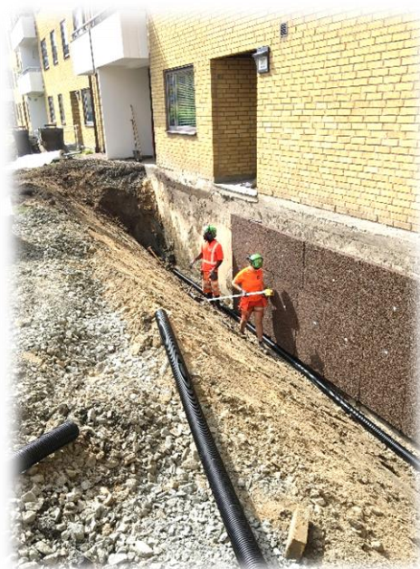
Ny dränering samt isolering av källarmur
