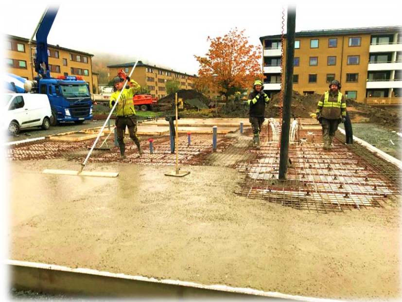
Gjutning av platta till nya tvättstugan
