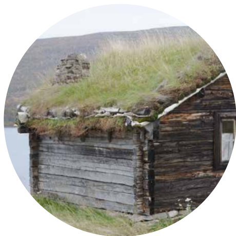
Vegetativa tak hjälper till att fördröja dagvatten vid kraftigt regn.
